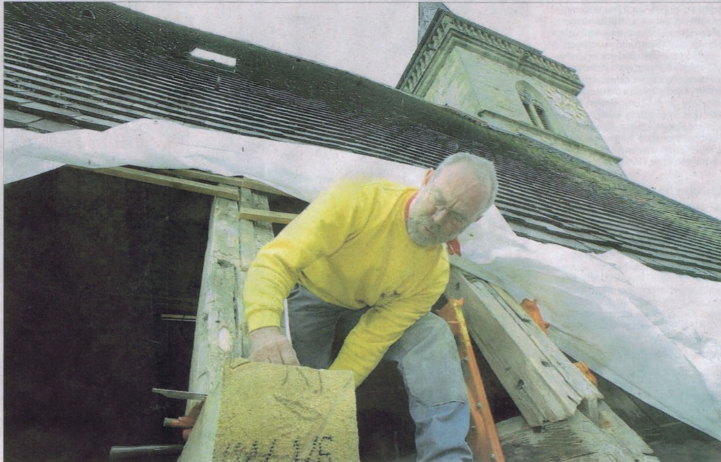
Zimmermann Harald Baum ist zurzeit mit der Dachreparatur in der Ingersheimer Martinskirche beschäftigt. Die Gesamtkosten für die Sanierung der morschen Holzkonstruktion schätzt die Kirchengemeinde auf 150 000 Euro. Foto: Martin Kalb
